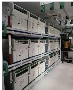
图 5 1.5 MW 10 kV AC-750 V DC 的 PET 样机
