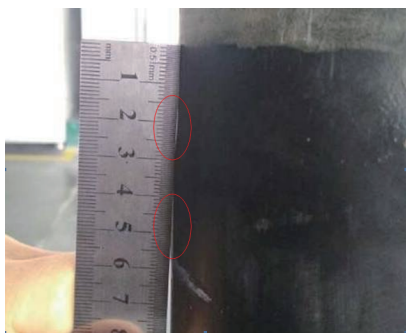
图1 终端击穿故障解体检测
