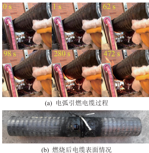
图 8 电弧引燃电缆实验
