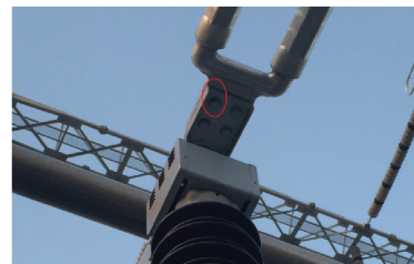
图4 缺陷发热点可见光图片
