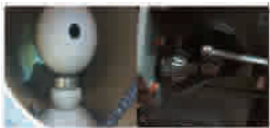
(a) 连续操作后的内部清理 (b) 储能电机的尼龙齿轮检查
