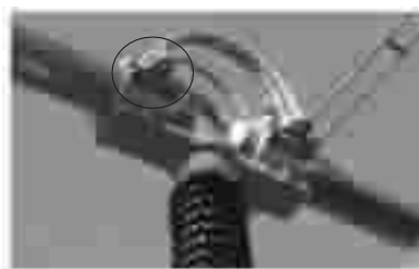
图 8 缺陷发热点可见光图片
