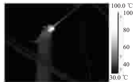
图 12 某 220 kV 刀闸 C 相刀口发热
