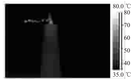
图1 某电厂2号主变B相
