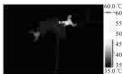
图 7 某 500 kV 电流互感器 C 相发热缺陷
