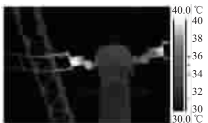
图 5 某 500 kV 电流互感器 C 相发热成像
